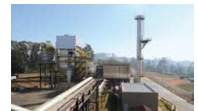
The Limeira Plant (Brazil)
